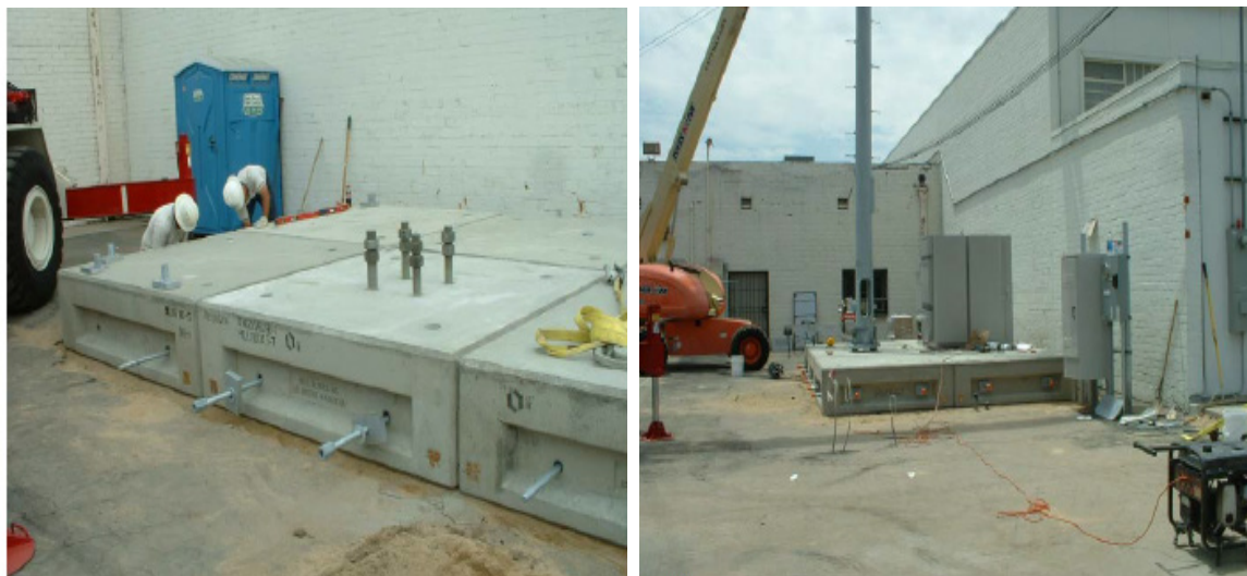
Рис. 3. Система сборно-разборного фундамента системы «Cell block».
